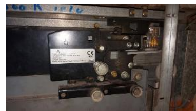
Serrure de porte palière du niveau principal
