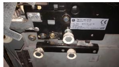
Serrure de porte palière du niveau principal
