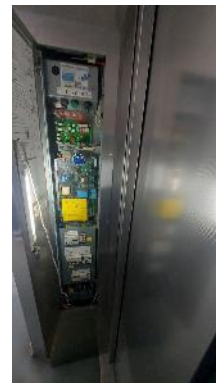
Baie palière avec armoire de commande
