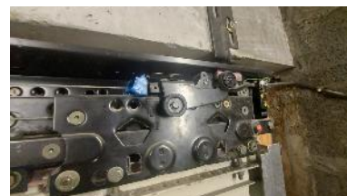
Serrure de porte palière du niveau principal
