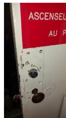
Commande palière du niveau principal
