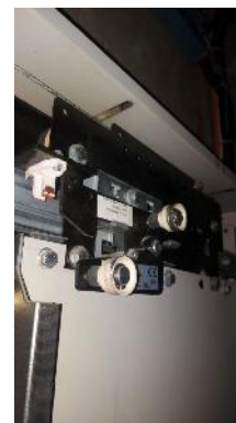
Serrure de porte palière du niveau principal
