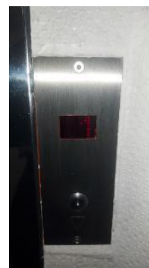
Commande palière du niveau principal
