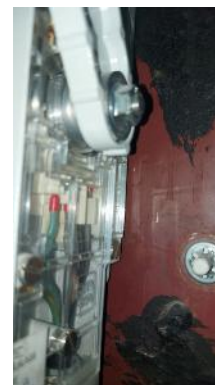
Serrure de porte palière du niveau principal
