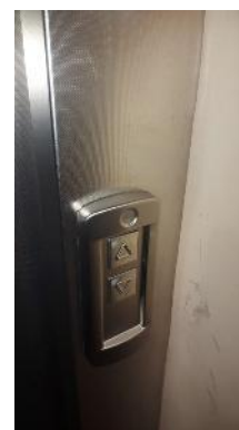
Commande palière du niveau principal
