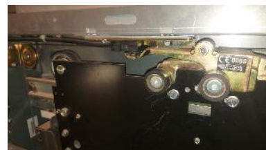
Serrure de porte palière du niveau principal
