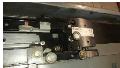
Serrure de porte palière du niveau principal
