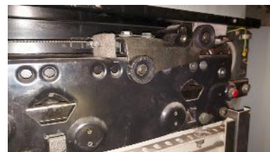
Serrure de porte palière du niveau principal
