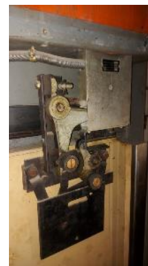
Serrure de porte palière du niveau principal
