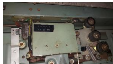
Serrure de porte palière du niveau principal
