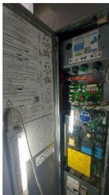
Dispositif de manoeuvre de secours au palier
