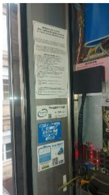
Dispositif de manoeuvre de secours au palier
