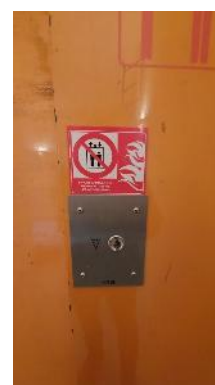
Commande palière du niveau principal
