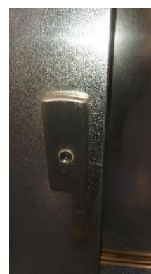
Commande palière du niveau principal
