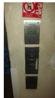
Commande palière du niveau principal
