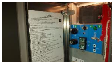
Dispositif de manoeuvre de secours au palier
