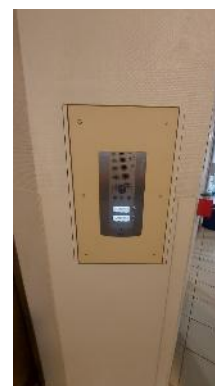
Commande palière du niveau principal
