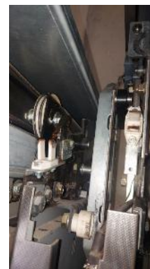
Serrure de porte palière du niveau principal
