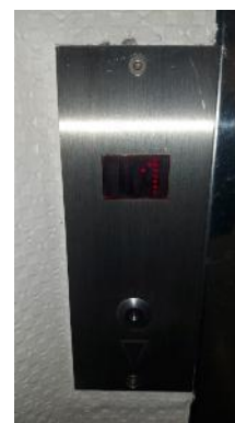
Commande palière du niveau principal
