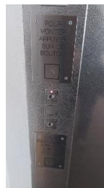
Commande palière du niveau principal
