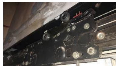
Serrure de porte palière du niveau principal
