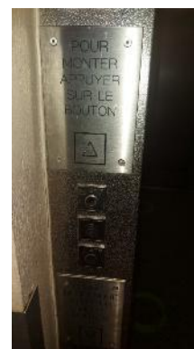
Commande palière du niveau principal
