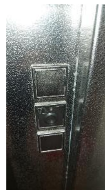
Commande palière du niveau principal
