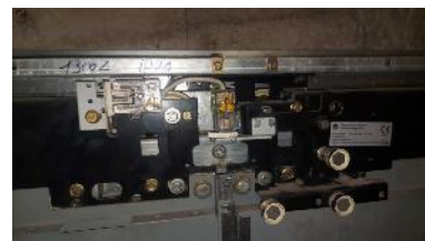
Serrure de porte palière du niveau principal
