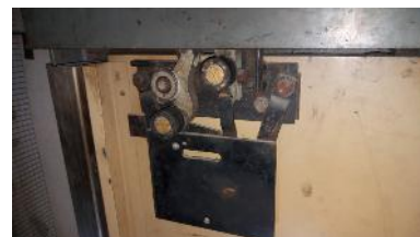
Serrure de porte palière du niveau principal
